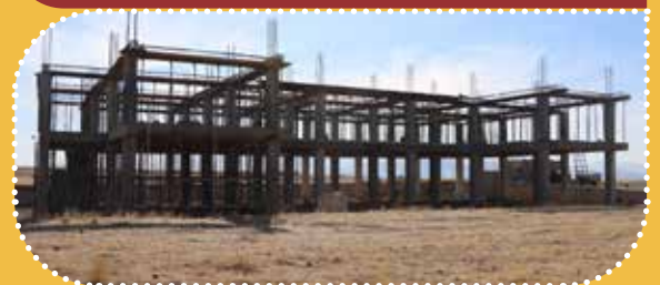
اجرای اسکلت بتنی خوابگاه متاهلین به مترار ۲۱۴۲ مترمربع و در سه طبقه
